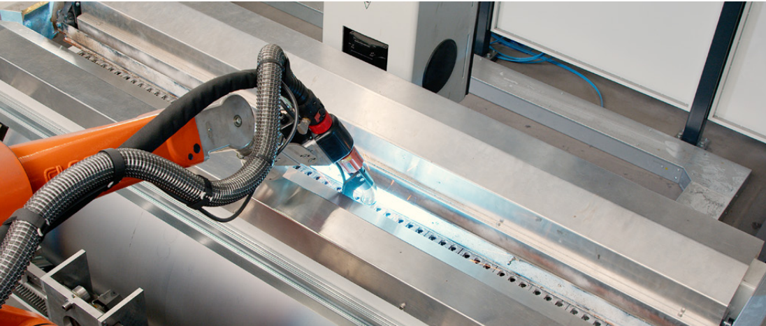
Jeder Fertigungsschritt ist auf maximale Effizienz, Präzision und Automatisierung ausgelegt.
